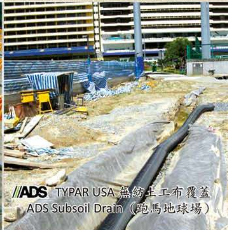
TYPAR USA 無紡土工布覆蓋 Stormtech 和 ADS Subsoil Drain (跑馬地公園)
