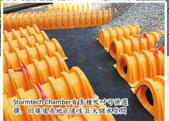
Stormtech 系統安裝非常簡單，不用任何重型機械，安全快捷
