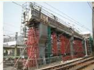
沙田火炭港鐵車廠工程
