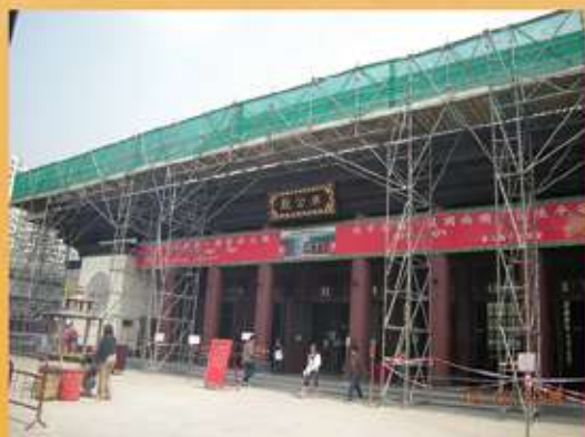
沙田車公廟改善工程
