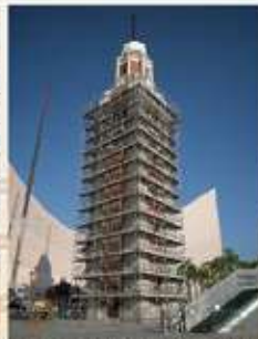
尖沙咀鐘樓維修工程
