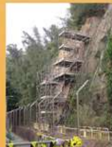
斜坡鞏固及維修鐵棚架工程
