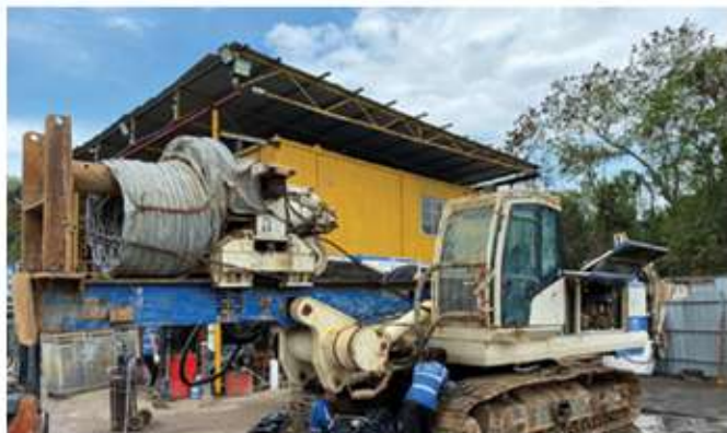
維修ENTECCO大型炮機
