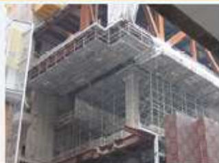
中環置地倒吊工作棚
