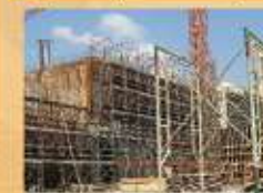
西鐵葵芳電力站工程
