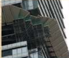
環球貿易廣場高空工程
