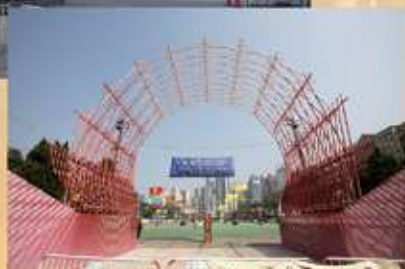
維園年宵棚架工程
