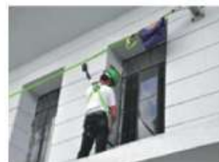
臨時水平防墮系統 長度：5m-20m 可供同時兩人使用
