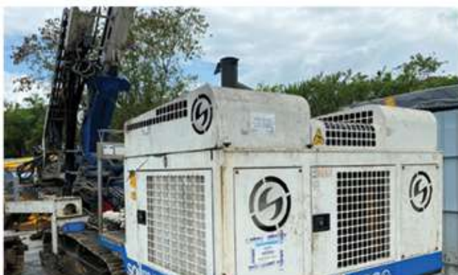
維修SOILMEC小型鑽機
